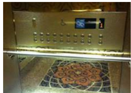
電梯內設置安全把手及專用電梯按鈕
