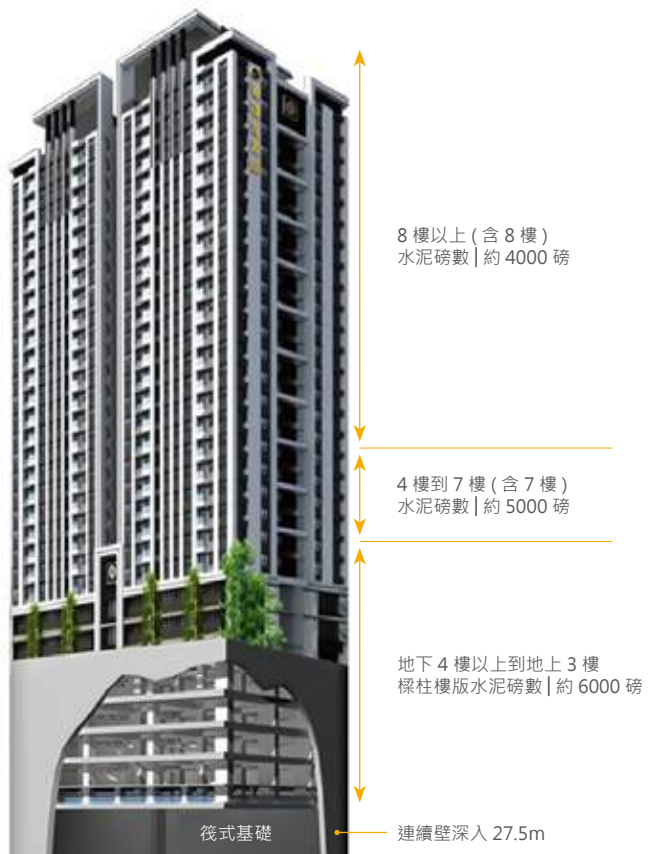
台南遠雄新源邸結構基礎設計
