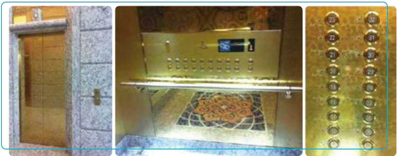
▲ 電梯內設置安全把手及專用電梯按鈕
